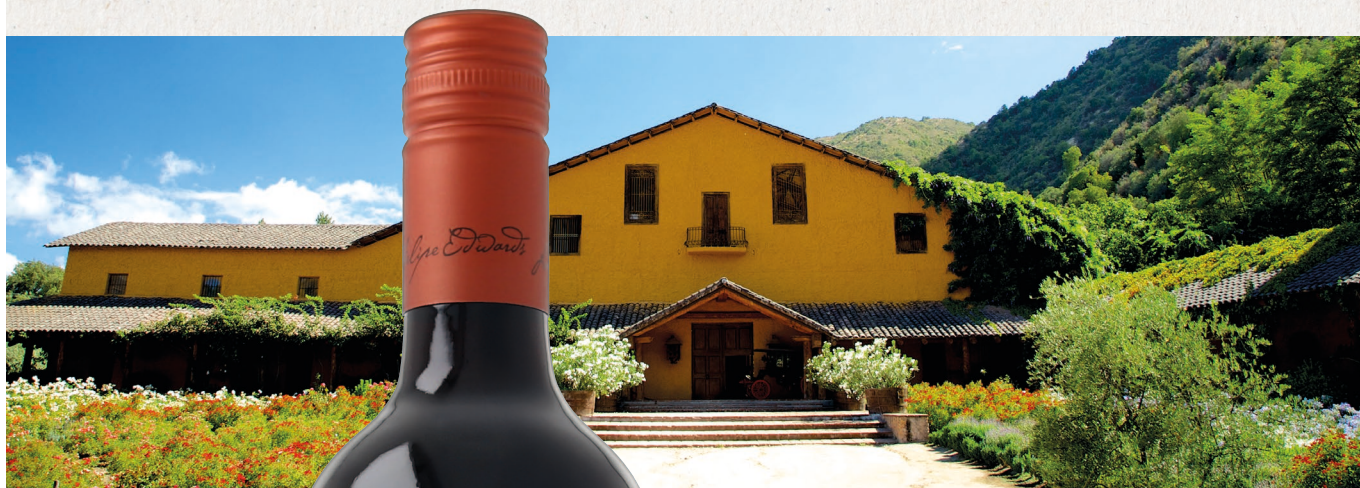
Traditionelles Produktionsgebäude der LFE Group im Herzen vom Colchagua Valley, Chile
